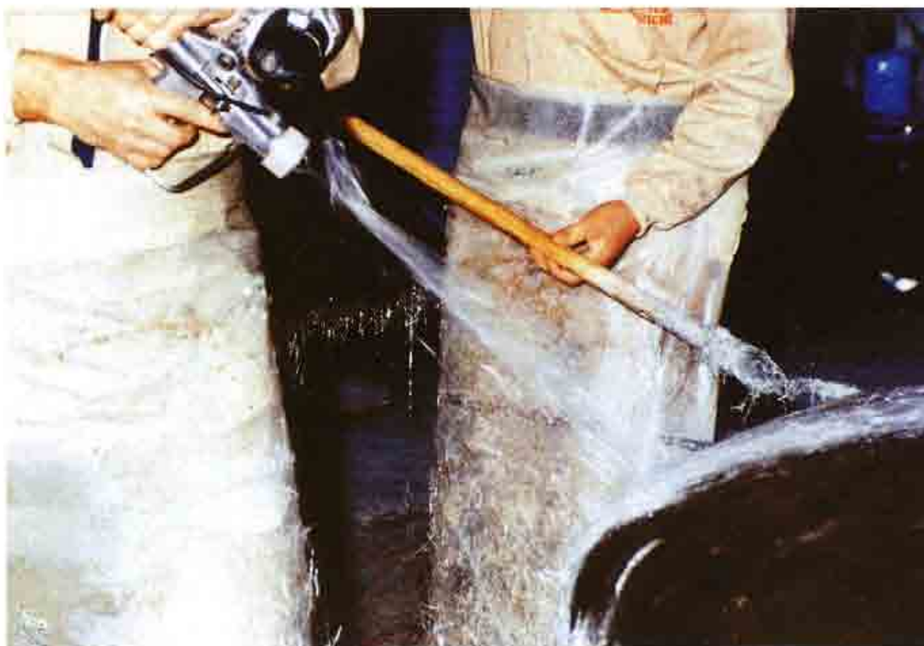
Aplicación simultánea de fibra de vidrio y resina por proyección.
