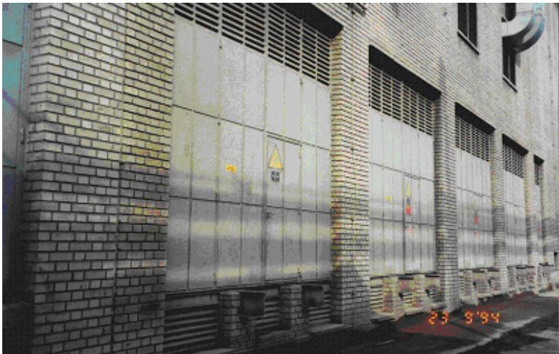
Ilustración 1: Salas de transformadores con acceso exclusivo desde el exterior y controlado.
