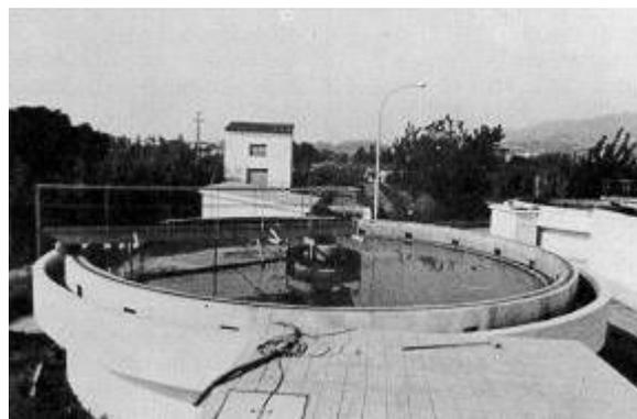
**Foto 2. Balsa de decantación elevada con el acceso sin protección**
