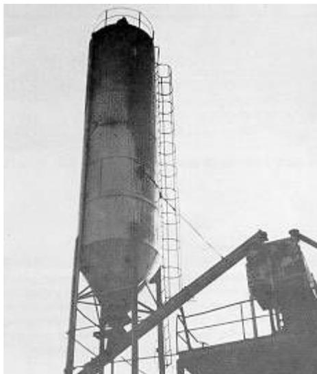
**Figura 2. Silo de cemento equipado con escala de "gato"**
