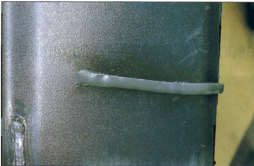
Soldadura realizada con baja temperatura.
