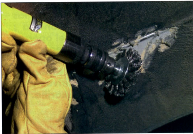
Eliminación de antigrilla con disco de acero trenzado.
