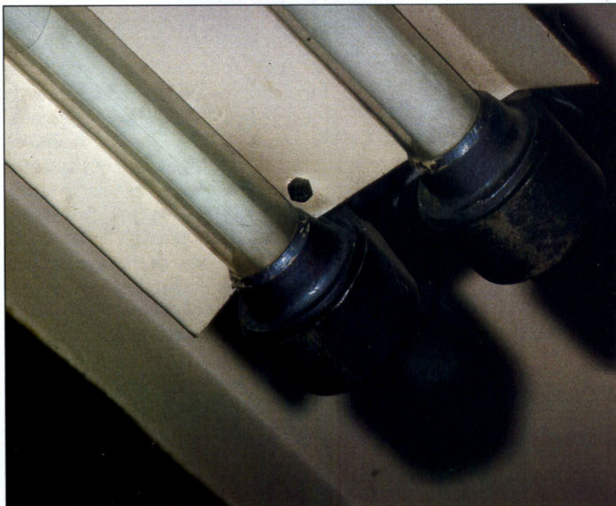
Luminarias con envolvente antideflagrante.
