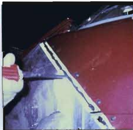
Aplicación de adhesivo sobre el refuerzo.
