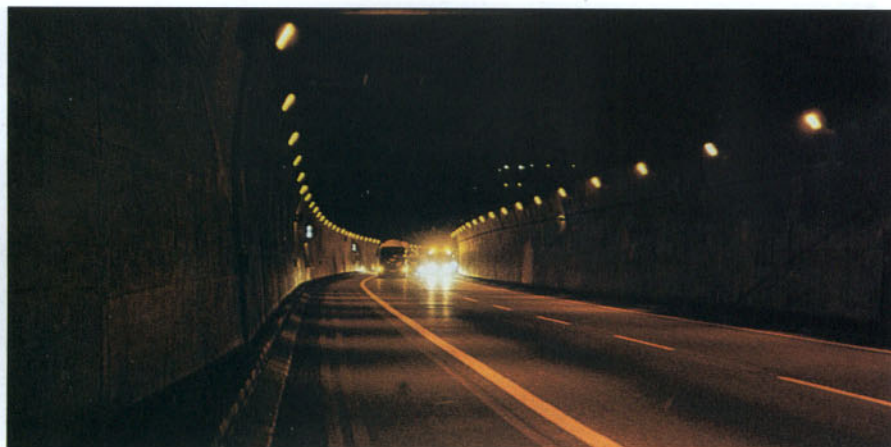
Interior de un túnel.
