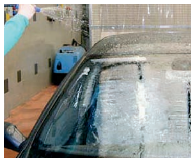
Aplicación de agua sobre la unión
