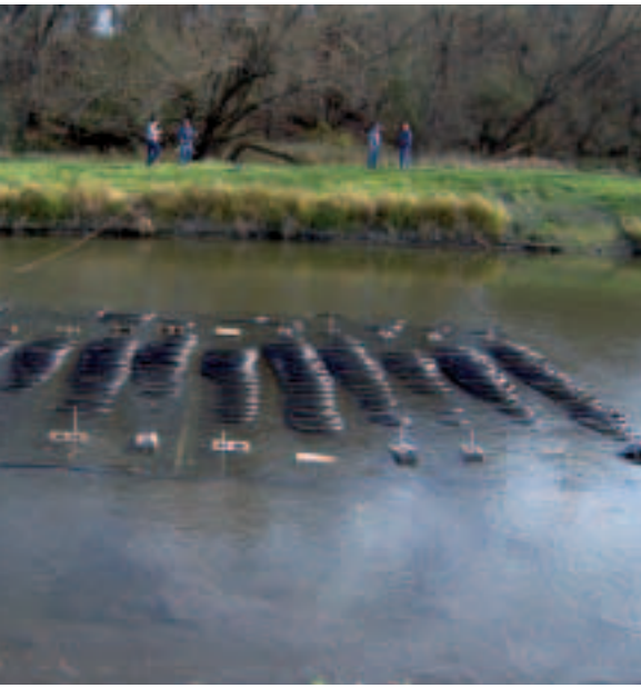
Izquierda, sistema de tuberías para calentar un estanque. Derecha, invernadero con calor geotérmico.
