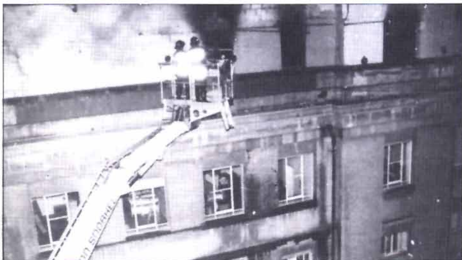
Figura 4: Foto del acceso cuarto. Obsérvese la rotura de la cornisa y la ausencia de cristales de las ventanas superiores
