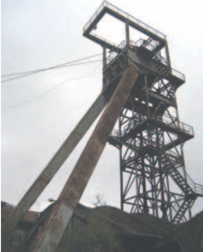
Figura 20. Vista del Pozo San José
