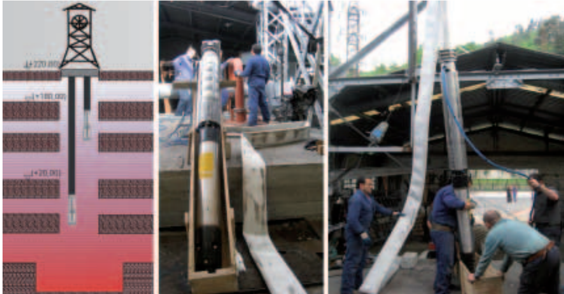
Figura 104. Sistema de bombeo instalado en el pozo Barredo (cortesía de HUNOSA)
