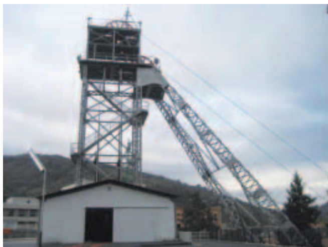
Figura 14. Vista del Pozo Barredo
