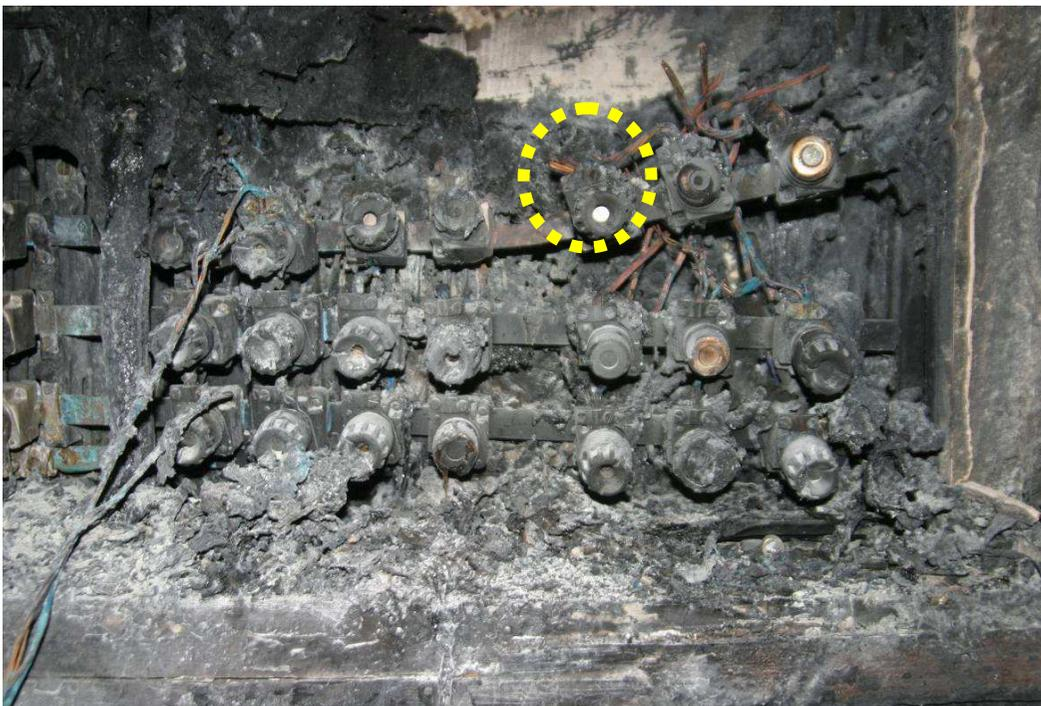
2: Vista del embarrado donde van colocados los fusibles que protegen los contadores situados aguas abajo. En la parte superior de la imagen se aprecia la huella por exposición directa de llama. Se aprecia parte del embarrado superior (círculo amarillo) fundido como consecuencia de fallo eléctrico. La ubicación de ambas marcas coincide.
