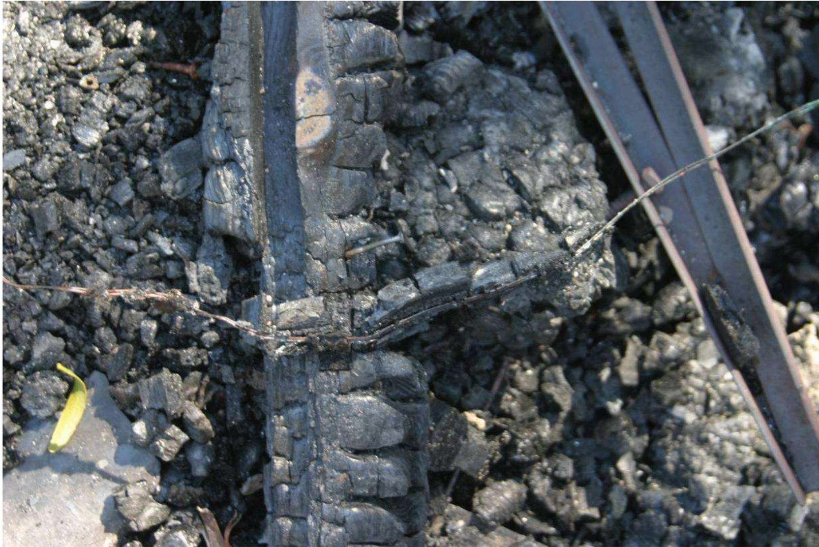
Detalle del cableado eléctrico que transcurre por el interior del tabique de madera sin mayor protección que el aislamiento del cable, lo que supone un riesgo intrínseco elevado de cara a un posible incendio por fallo eléctrico.
