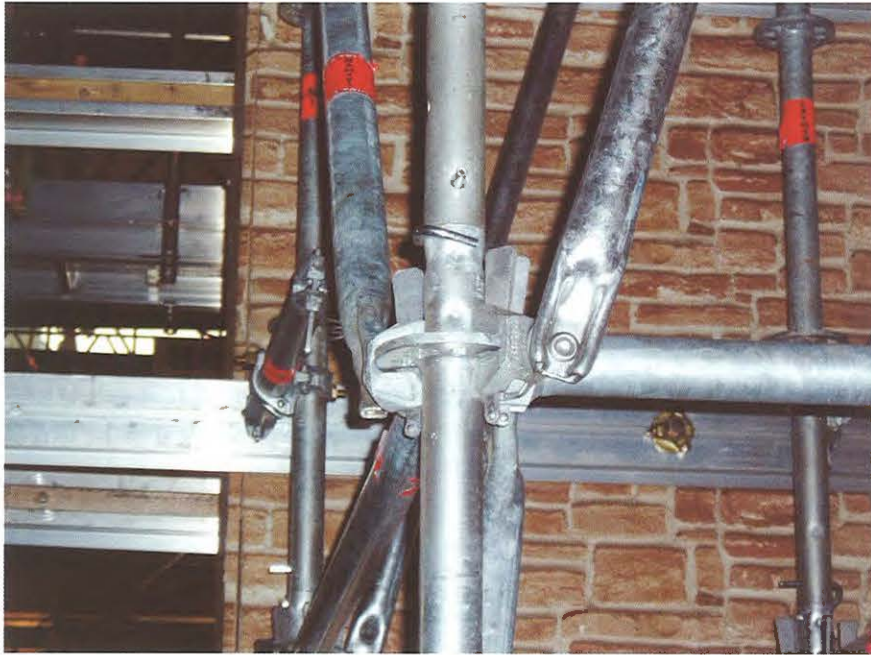
Figura 2.9 Detalle de nudo de un andamio normalizado multidireccional. (fuente: propia)
