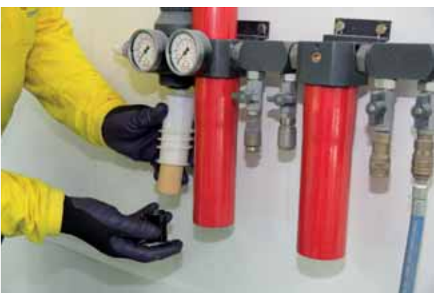
► Sustitución de los filtros de aire comprimido
