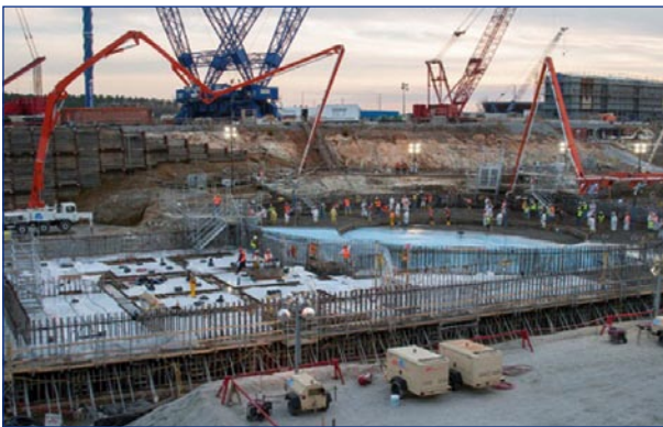
Hormigonado en Summer © SCE&G.
