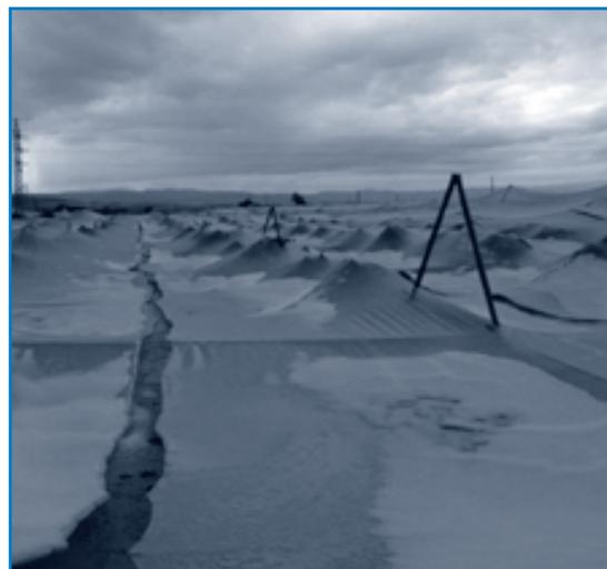
Hundimiento de un invernadero provocado por pedrisco.
