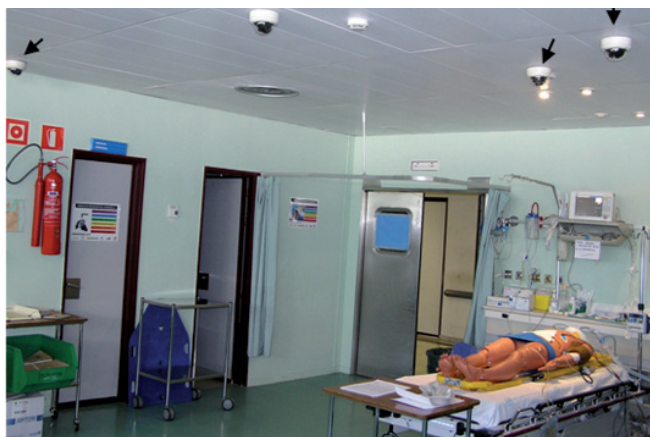
Figura 1. Instalación Sistema Videograbación.
