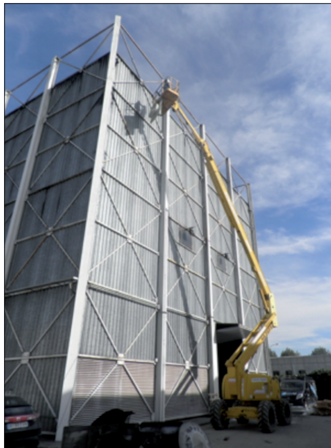
Figura 6. Proceso de montaje de los ventiladores.
