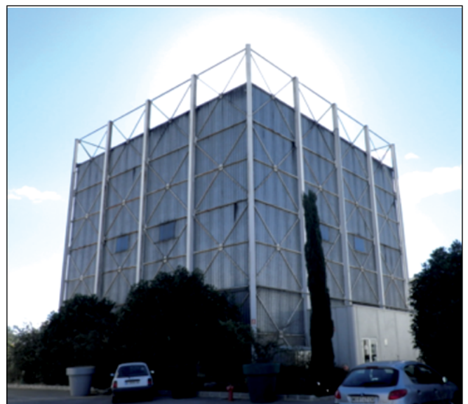
Figura 1. Nave del Fuego del Centro Tecnológico del Metal (Murcia).
