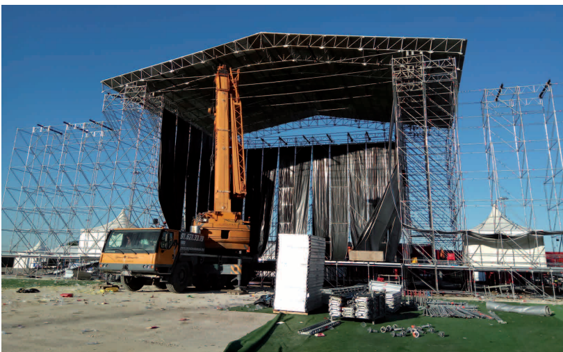
■ Figura 2 ■ Desmontaje de estructura de escenario
