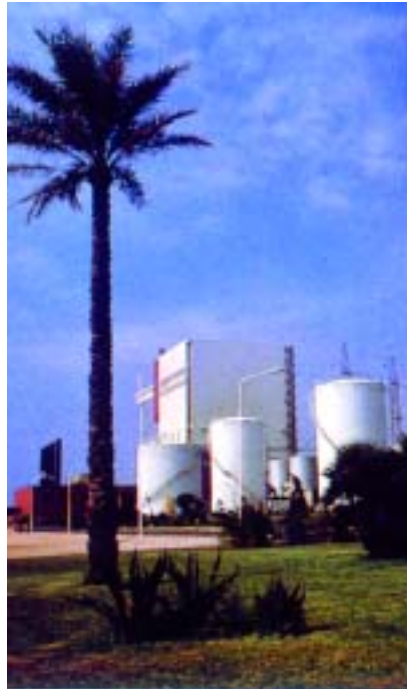
Central nuclear de Vandellós-I
