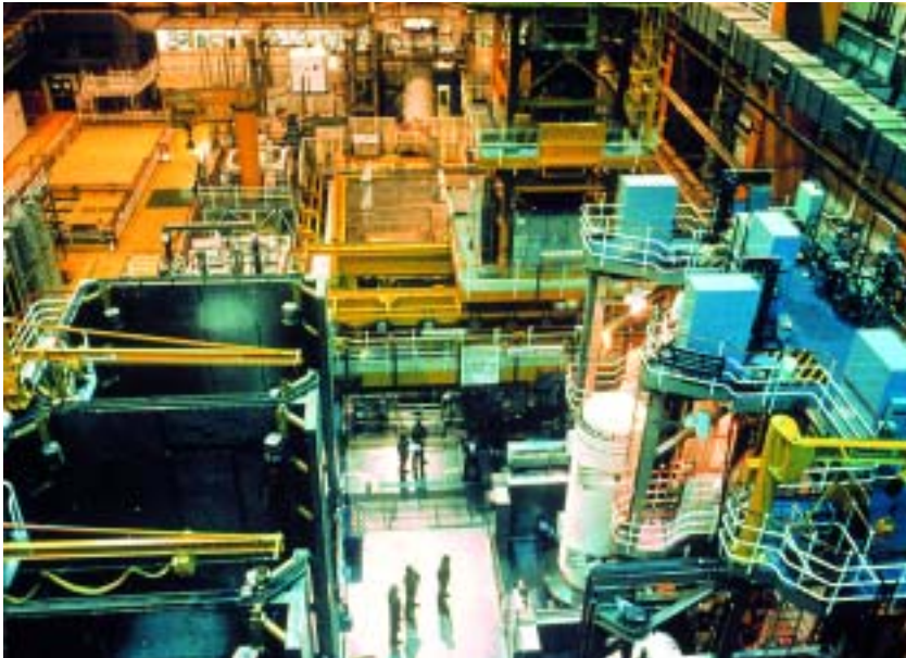
Planta de reproceso de combustible gastado de Sellafield (Reino Unido)
