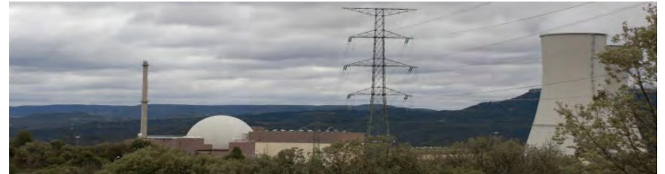
La central nuclear de Trillo dispone de un almacén temporal en seco, en el que se almacena una parte del combustible gastado en el interior de contenedores metálicos, totalmente herméticos y blindados. Con una superficie de 2.280 metros cuadrados, este almacén está diseñado para albergar 80 contenedores.
