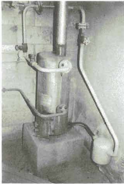
Vaporizador de llama directa. Peligroso
