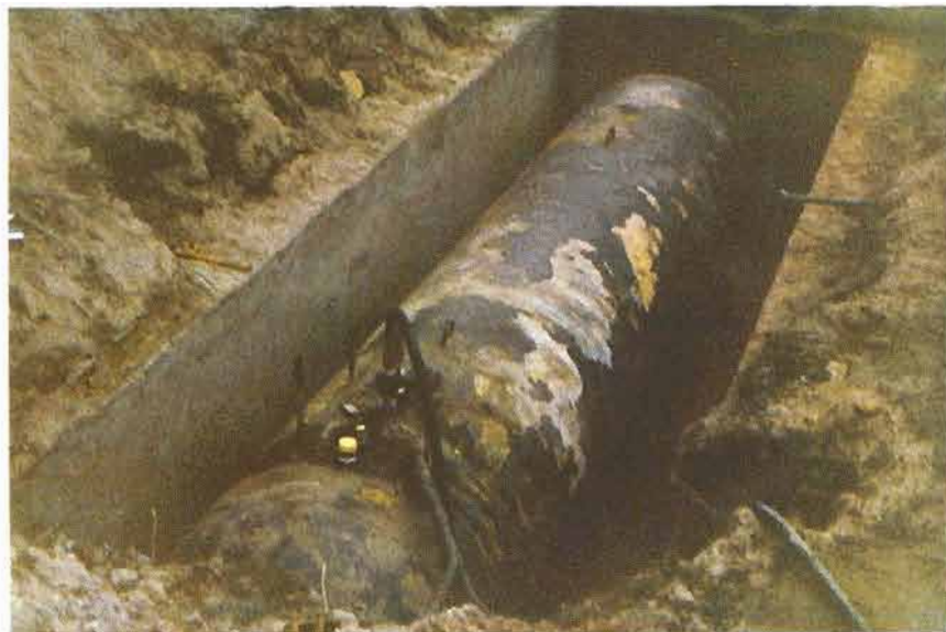
Depósito enterrado en proceso de prueba hidráulica
