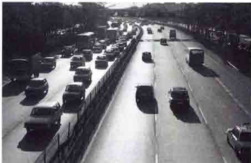
La seguridad vial depende de la vía, el vehículo y del comportamiento del conductor.
