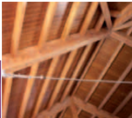
Fotos 7 y 8. Instalación de panel sándwich de madera y aspecto desde el interior del edificio.
