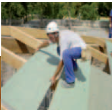
Fotos 7 y 8. Instalación de panel sándwich de madera y aspecto desde el interior del edificio.
