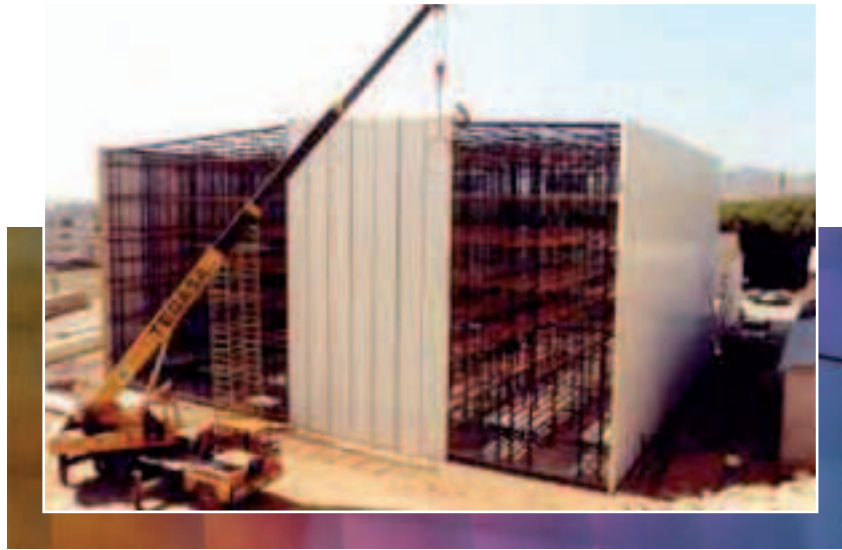
Montaje de una instalación con paneles sándwich. Fuente: Aiconsas.
