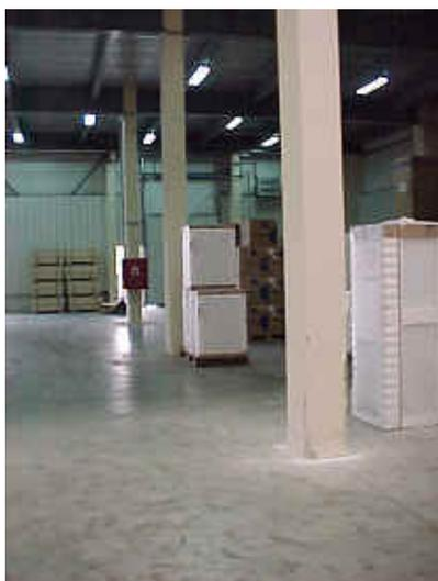
**Ilustración 7: Pilares metálicos protegidos por paneles**
