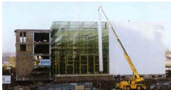
Ilustración 2: Montaje de un panel sándwich formando la cubierta y paramentos.
