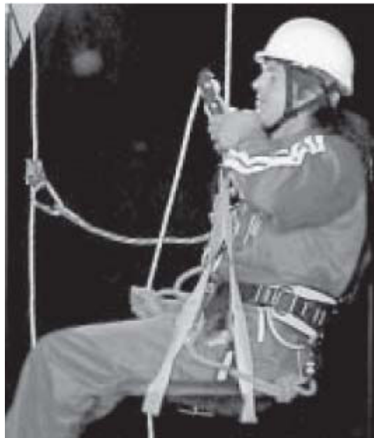
Figura 1 Descenso mediante descendedor autoblocante y dispositivo anticaídas
