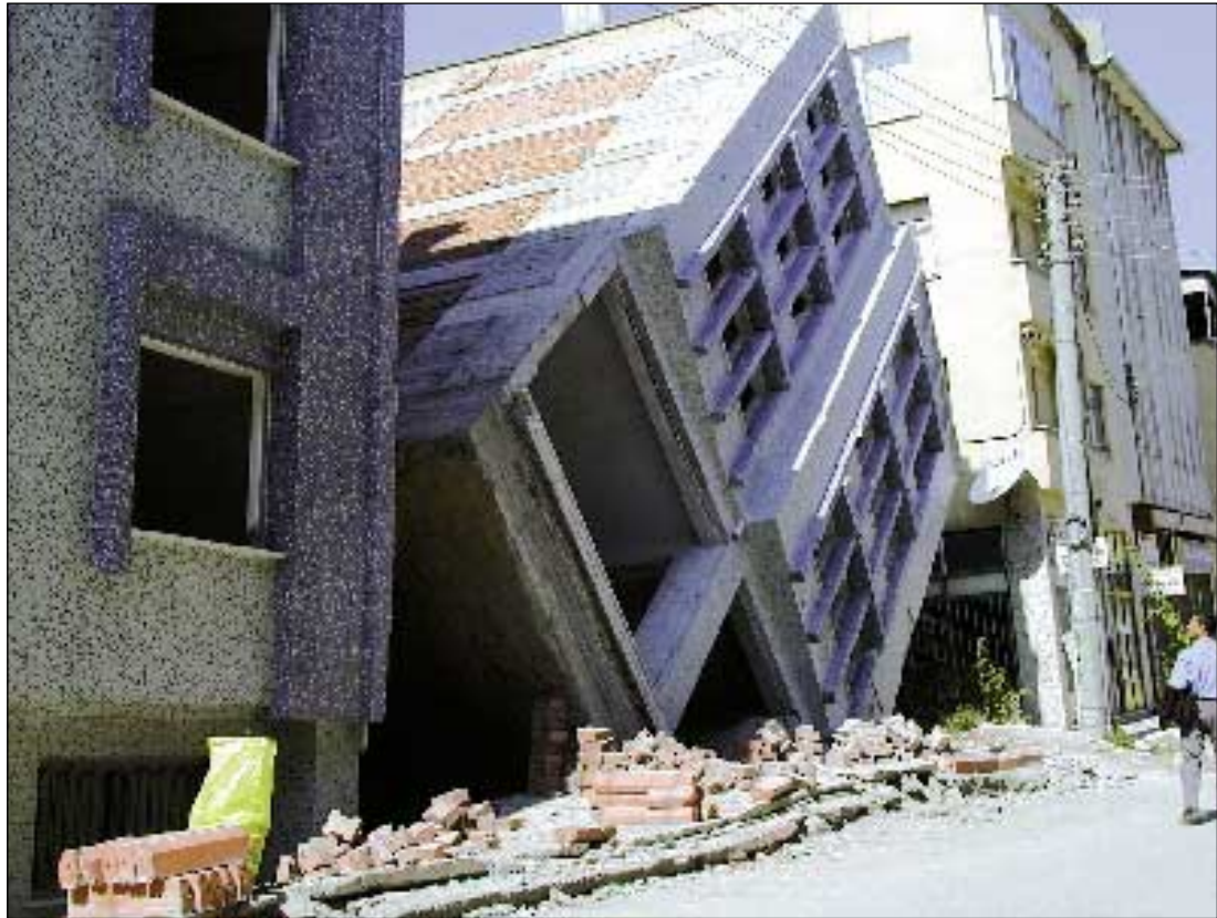
Edificio volcado por licuefacción del suelo y aceleración intensa en Adapazari, Turquía.
