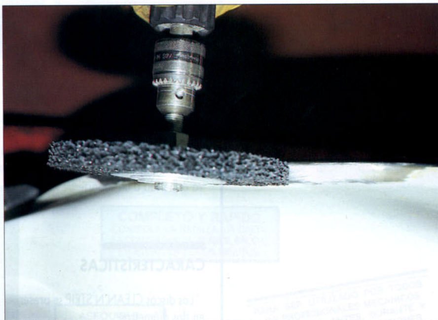
Lijado de pinturas en zonas de difícil acceso.
