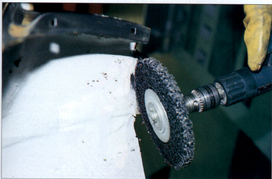
Eliminación de revestimientos anticorrosivos.
