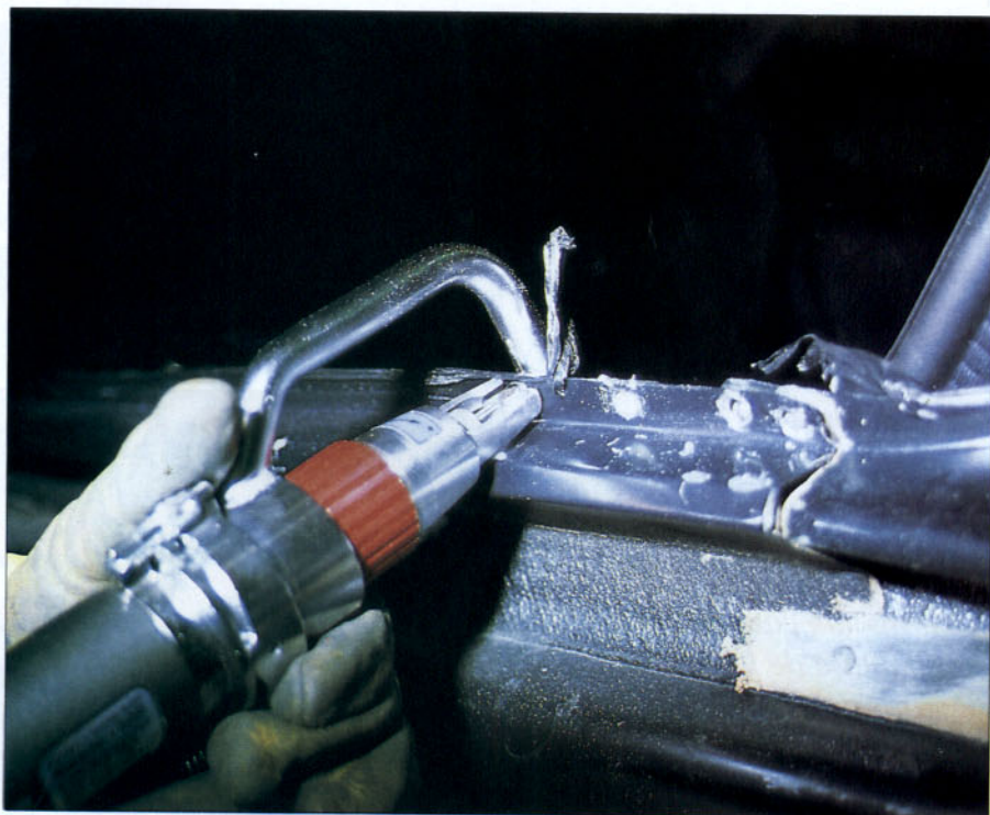
Despunteado con la VARIO DRILL WS-90
