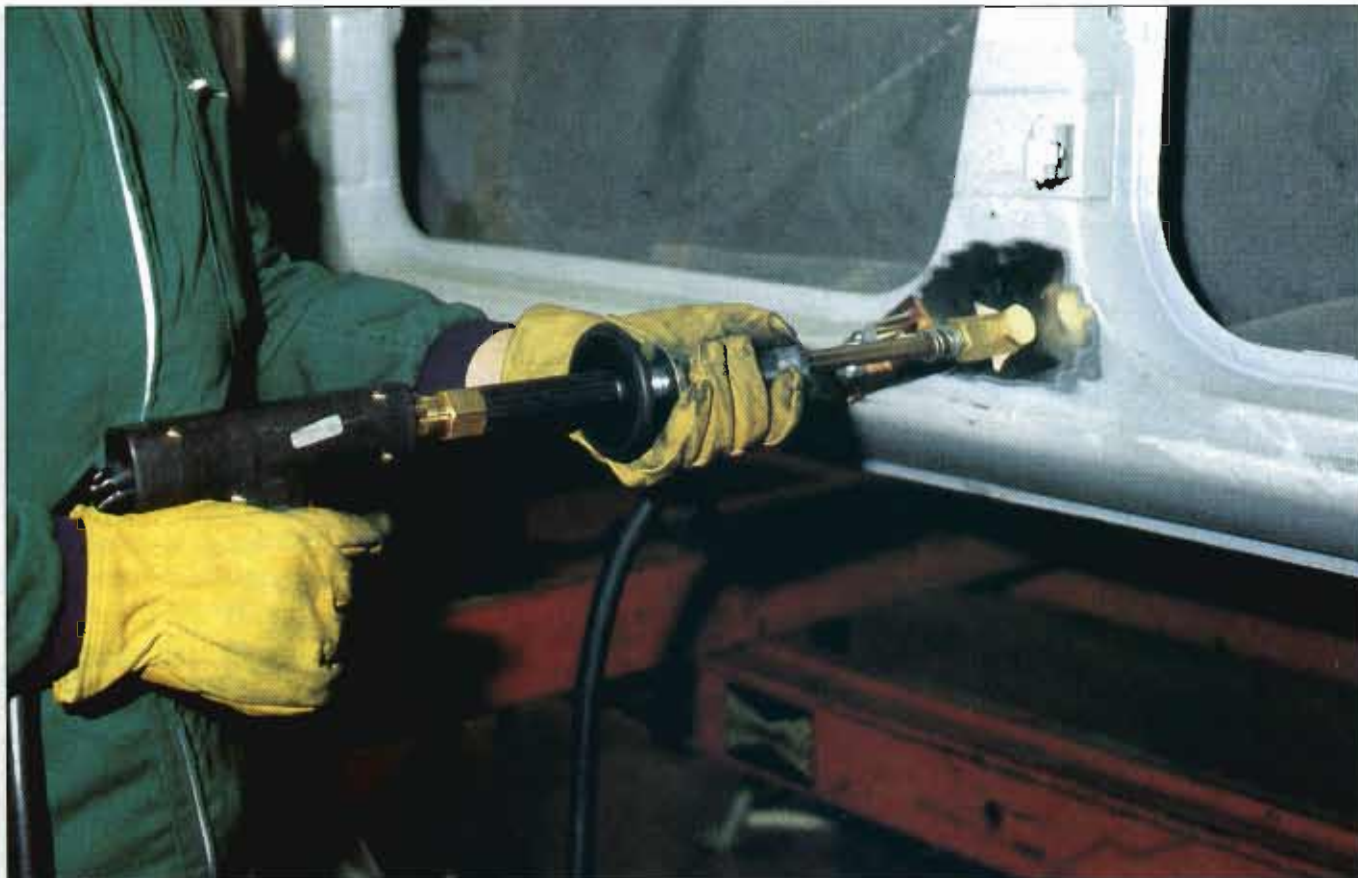
Soldadura-estirado de chapa mediante anillos especiales.
