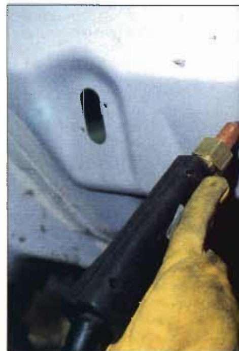
Soldadura de espárragos.
