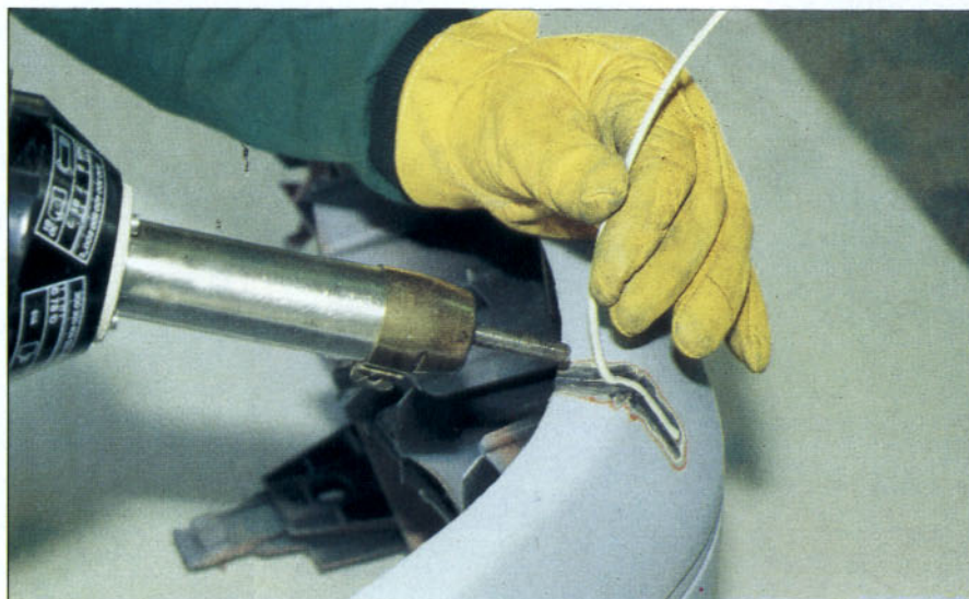
Soldadura de piezas de plástico.
