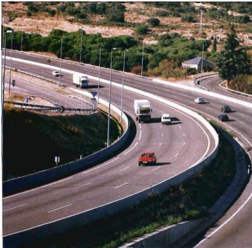
Barrera de hormigón.
