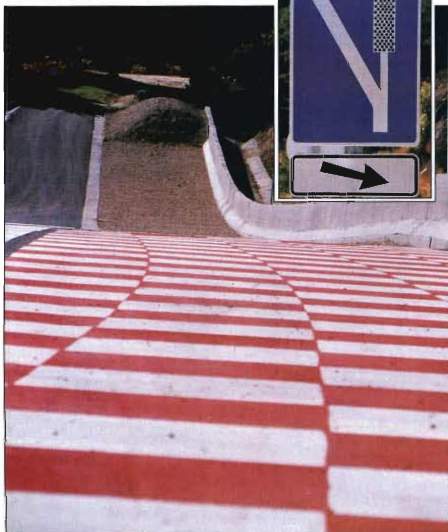
Lechos de frenado de emergencia.
