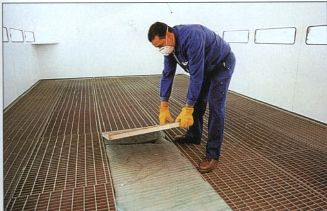
Sustitución de filtros de suelo.
