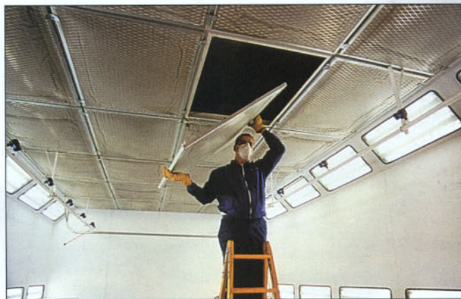
Sustitución de filtros de "plenum".
