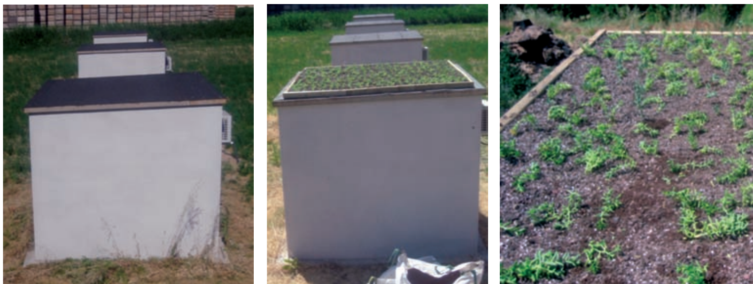
Figura 4. Vista del cubículo durante la instalación de la cubierta verde.
