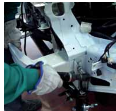
Proceso de sustitución de la traviesa
