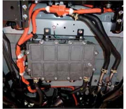
▶ Acceso a la batería
