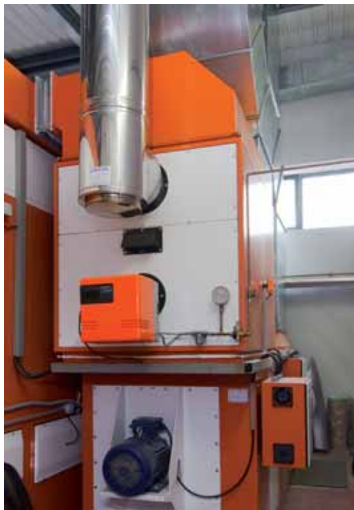
► Quemador y hogar para atemperar la cabina
