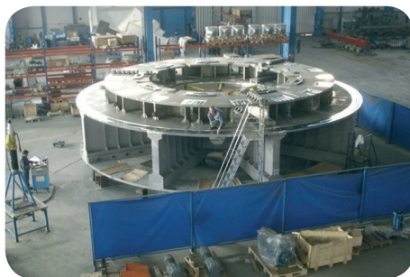
Pre-montaje de la base de criostato en Avilés (© ITER).
