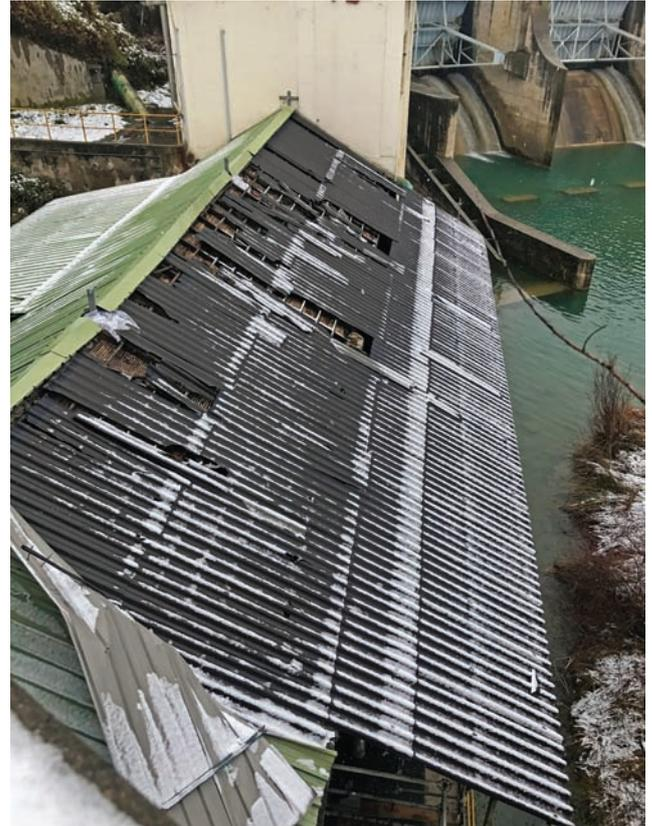
Figura 4. Cubierta de fibrocemento en mal estado.
