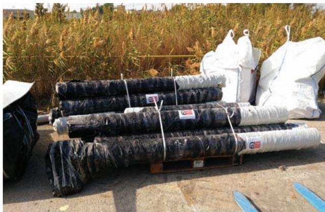
Figura 16. (a) Residuos de amianto acondicionados y acopiados para su retirada.
