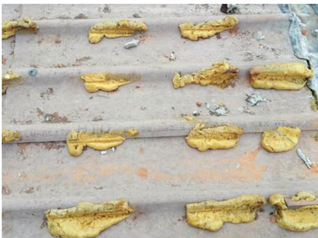
Figura 1 (a) Placas onduladas de fibrocemento fabricadas con amianto (AT).
