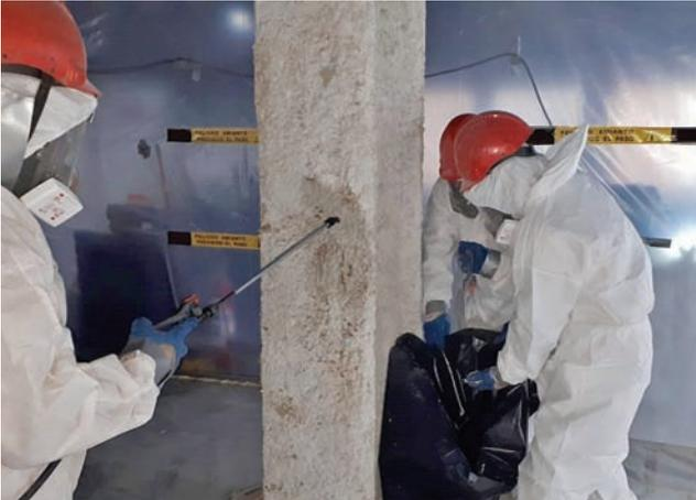
Figura 11. Humectación de materiales con amianto para facilitar su retirada manual.
