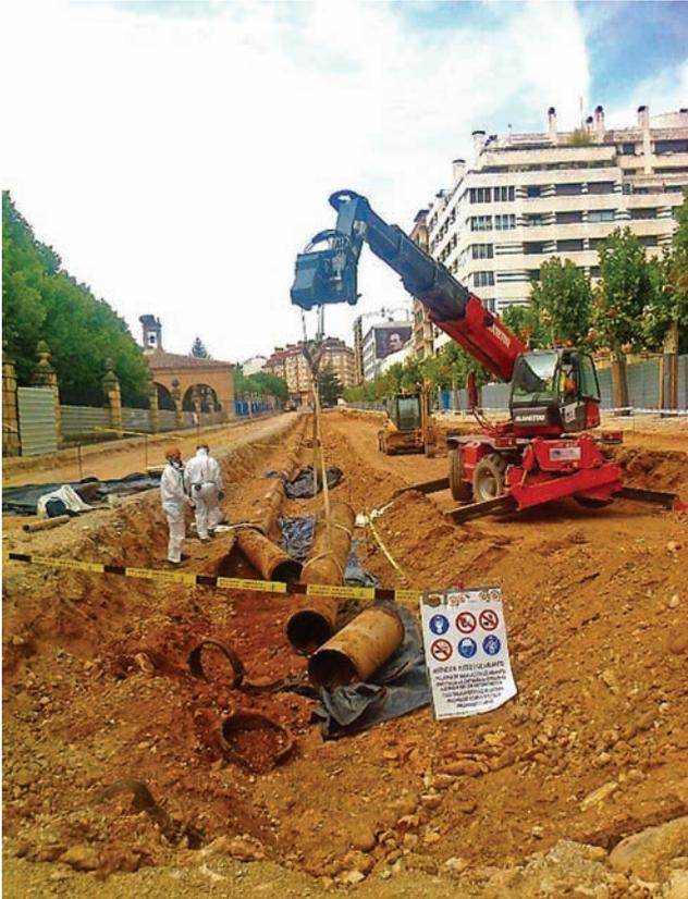
Figura 3. Señalización y acotamiento de la zona de trabajo en la sustitución de tuberías de amianto-cemento.
