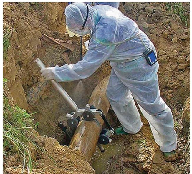
Figura 12. (b) Corte de tubería con aporte de agua para la retirada de materiales con amianto.
