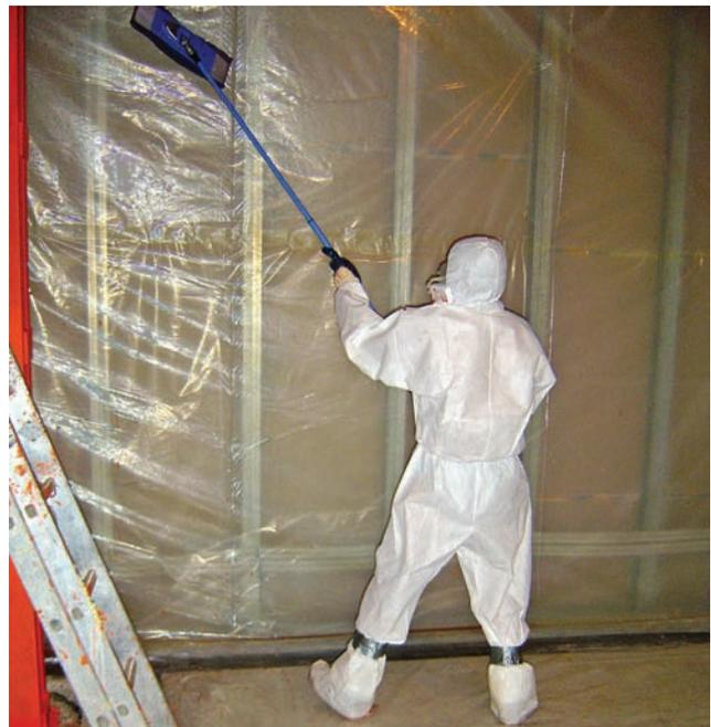
Figura 14. (b) Limpieza de superficies y plásticos mediante bayeta impregnada con agente fijador.
