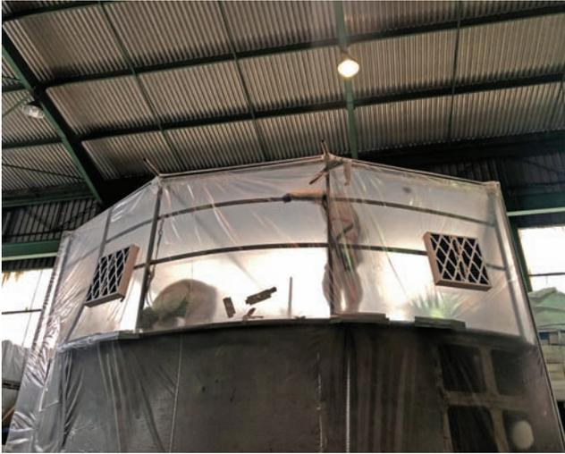
Figura 8. (a) Confinamiento con toma de aire.
