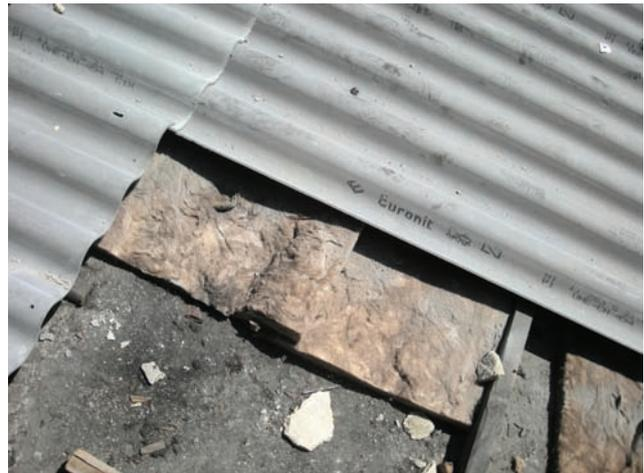
Figura 1 (b). Placas onduladas de fibrocemento fabricadas sin amianto (NT).
