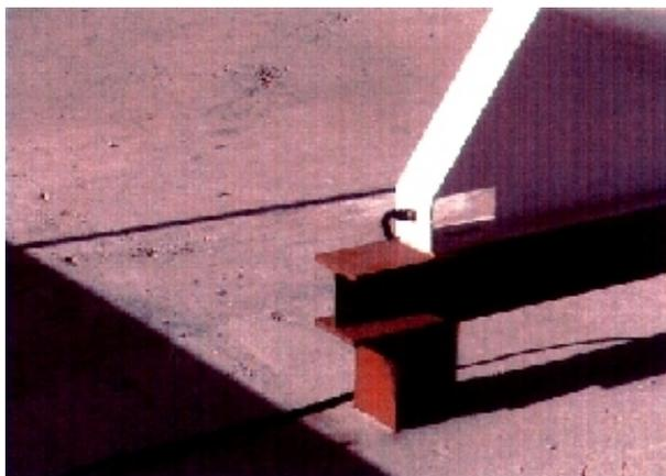
La Puesta a Tierra tiene como objeto, por tanto, limitar la tensión que con respecto a tierra, puedan presentar las masas metálicas así como garantizar la actuación de las protecciones y eliminar o disminuir el riesgo que supone una avería en el material utilizado.
