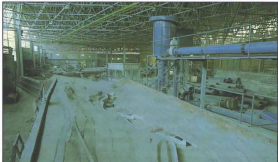
Nave para ensayos de modelos hidráulicos continentales. (Foto 2).
