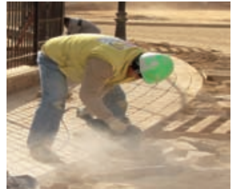
Figura 3. Trabajo realizado con amoladora grande.
