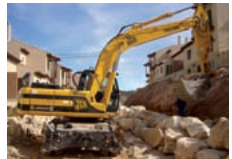
Figura 11. Trabajo realizado con maquinaria pesada.
