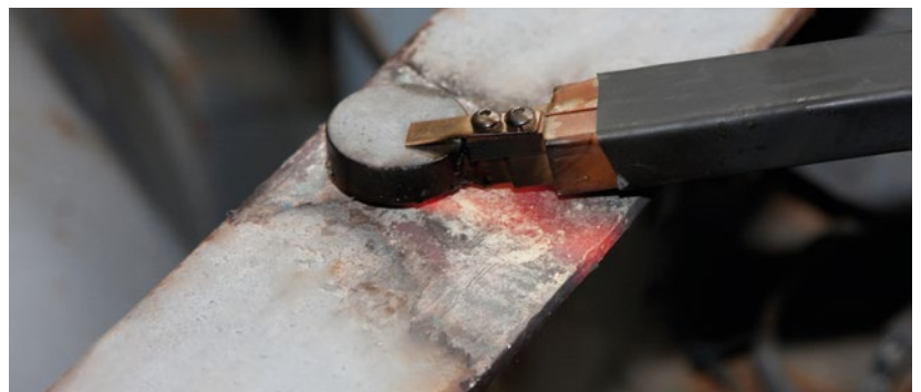
► Aplicación de calor en un larguero mediante un equipo de inducción
