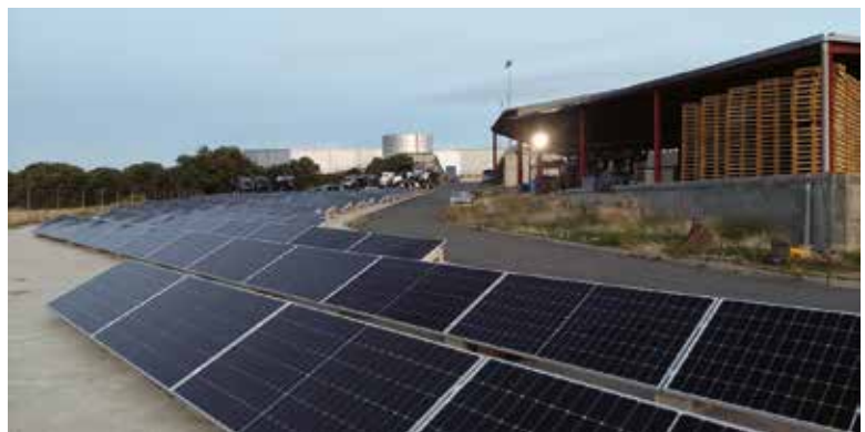
1 a 3: Sede Majadahonda de MAPFRE: vista aérea, cubiertas solares y placas para coches
