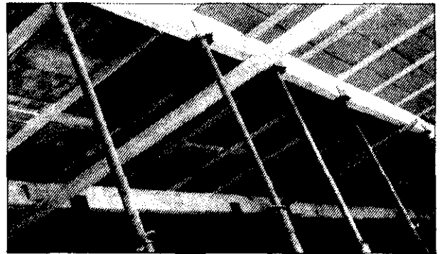
Apuntalamiento del forjado.
