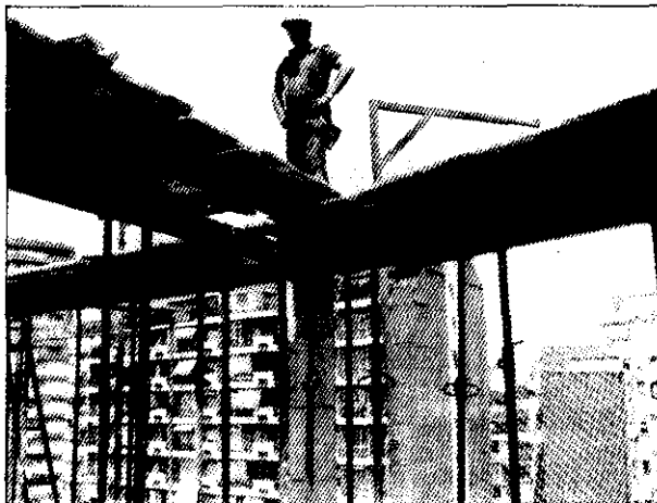
Colocación de tableros.
