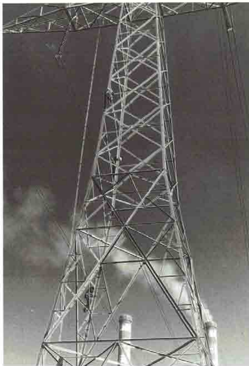
FIGURA 17. Vista general del trabajo de una brigada dotada del equipo especial para subida y desplazamientos en apoyos de línea.
