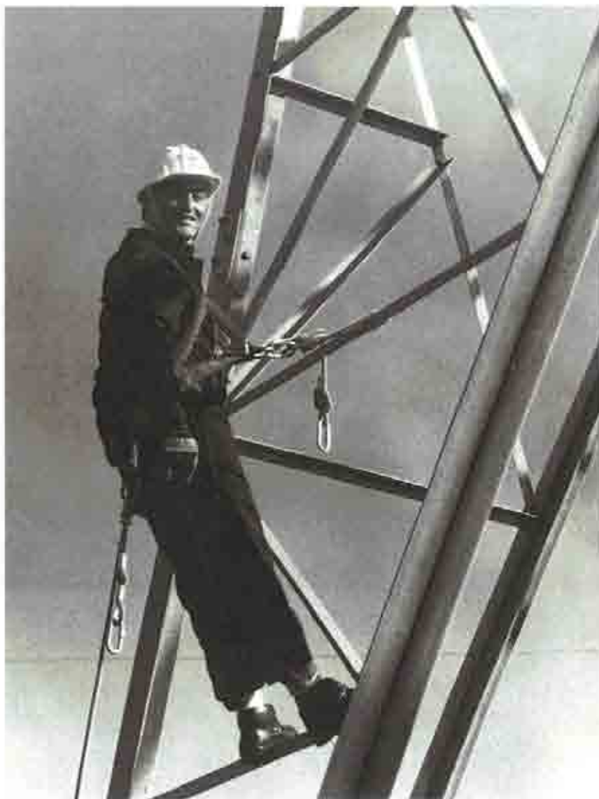
FIGURA 1. El operario que sube en primer lugar muestra durante un momento del ascenso la forma de sujeción del arnés de seguridad a la cinta de anclaje.
