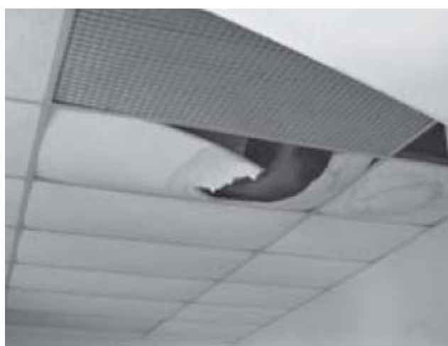
Figura 6 Placas de falso techo con contenido en amianto
