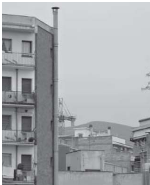
Figura 10 Conducto de aireación de fibrocemento
