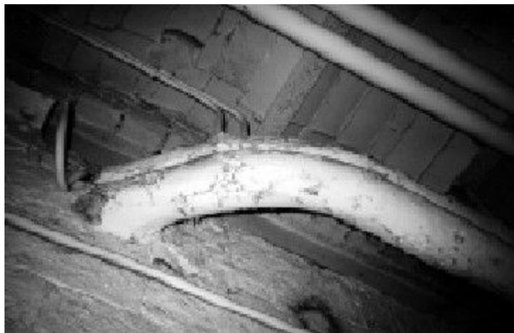
**Figura 3. Calorifugado de una tubería con material con crisotilo, que requiere reparación.**
